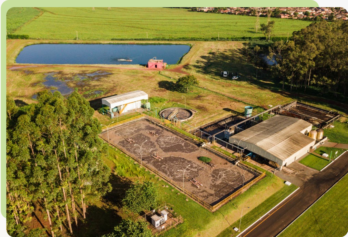
Estação de Tratamento de s (ETE) – Complexo Industrial Itumbiara (GO)
